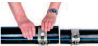
Schellen über die zu verbindenden Rohre schieben.
