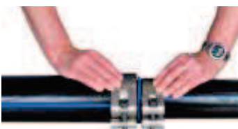
Schellen bündig mit den Rohrenden positionieren.
