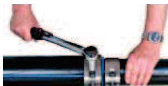
Schrauben mit dem Drehmoment-schlüssel auf das angegebene Anzugs-moment anziehen.
