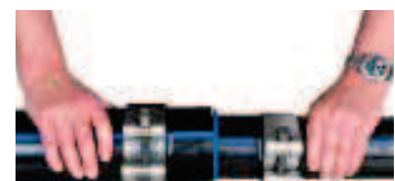
Zweites Rohr bis zum Anschlag auf die Reduktion schieben.
